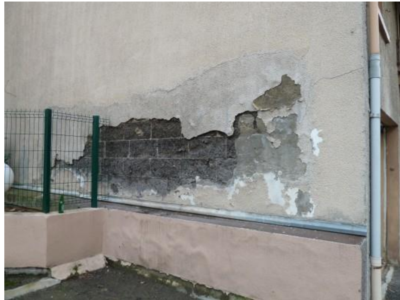
Béton de mâchefer banché (gauche) et en blocs maçonnés (droite)
